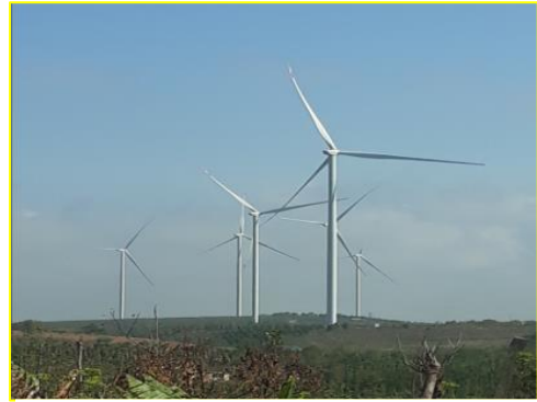
Hình 2.9. Điện gió tại huyện Đắk Song (Ảnh: Minh Thảo)
